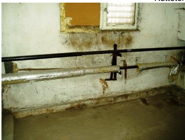
Kahjustada saanud küttetorustiku isolatsioon.
