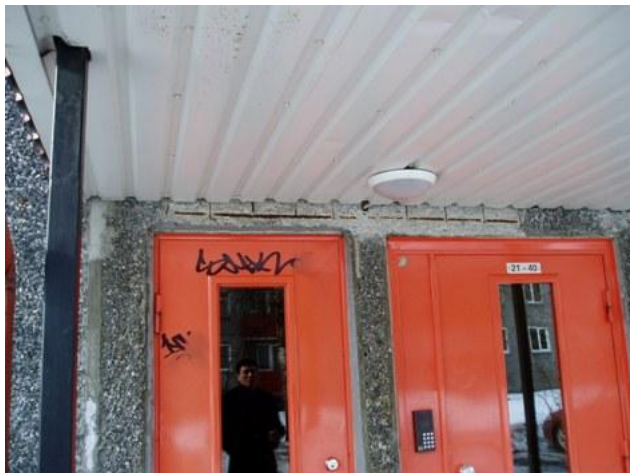
Seinapaneeli armatuur väljas.
