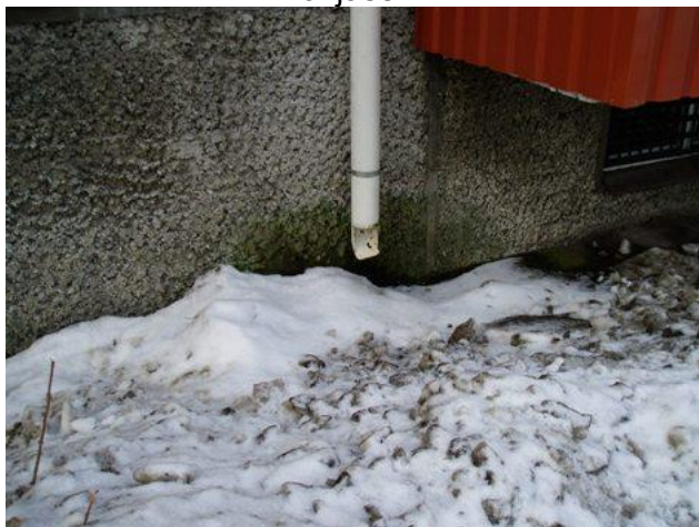
Sadeveetorust tulenev vesi pritsib soklile.
