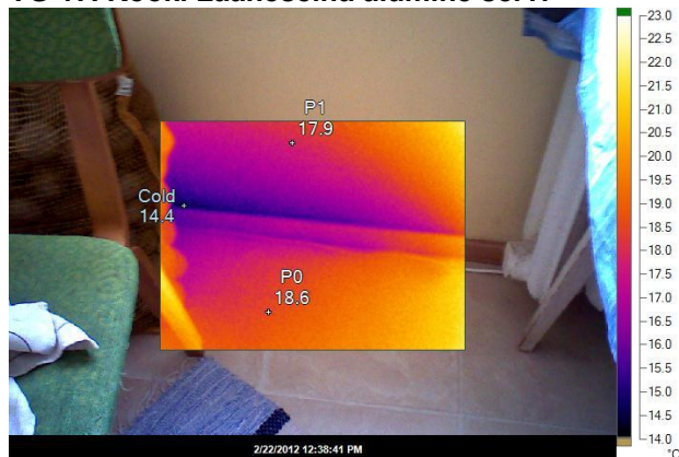
TG 17. Köök. Lääneseina alumine serv.
